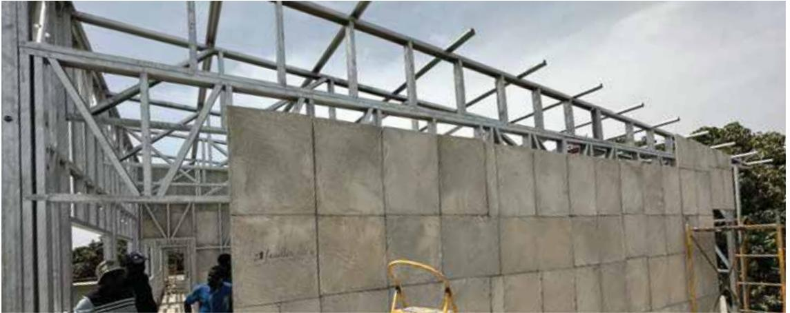
Le béton allégé produit par CSTM est un béton dans lequel est injecté une mousse pour réduire la densité du produit fini. Les plaques sont fixées sur la structure métallique par des vis
