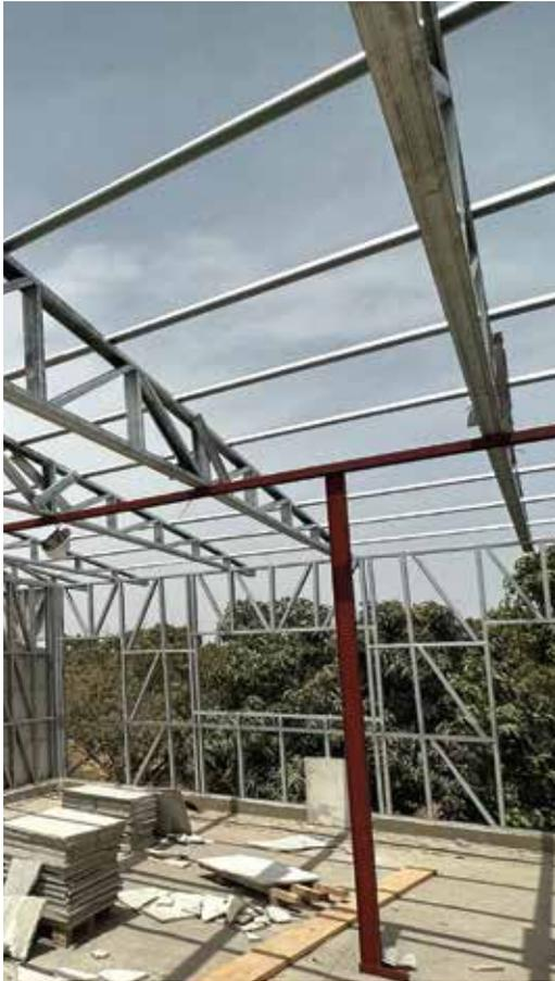
Le matériel de base est un acier de dureté **G550**, d'épaisseur **0.9 mm (TCT)** revêtu d'aluzinc® à **150 gr par m2**, formé à froid dans une profileuse dédiée
